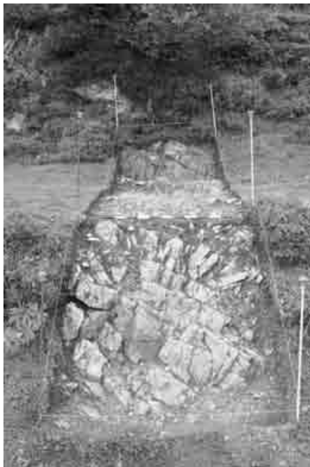
LÁMINA IX. Plataforma antigua de la vía con talud en roca, cortada a su vez por la calzada actual en gran parte construida, entre 1582 y 1584, para el traslado del mausoleo del Inquisidor General F. Valdés Salas.
